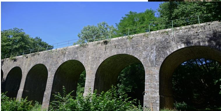
Aqueduc du Gué de la Roche: édifié sur 76,40m, cet ouvrage d'art compte 10 arches d'une ouverture de 5m. de diamètre.
