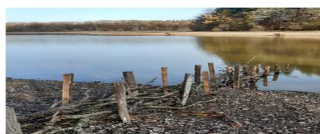
Lignes de pieux immergés
